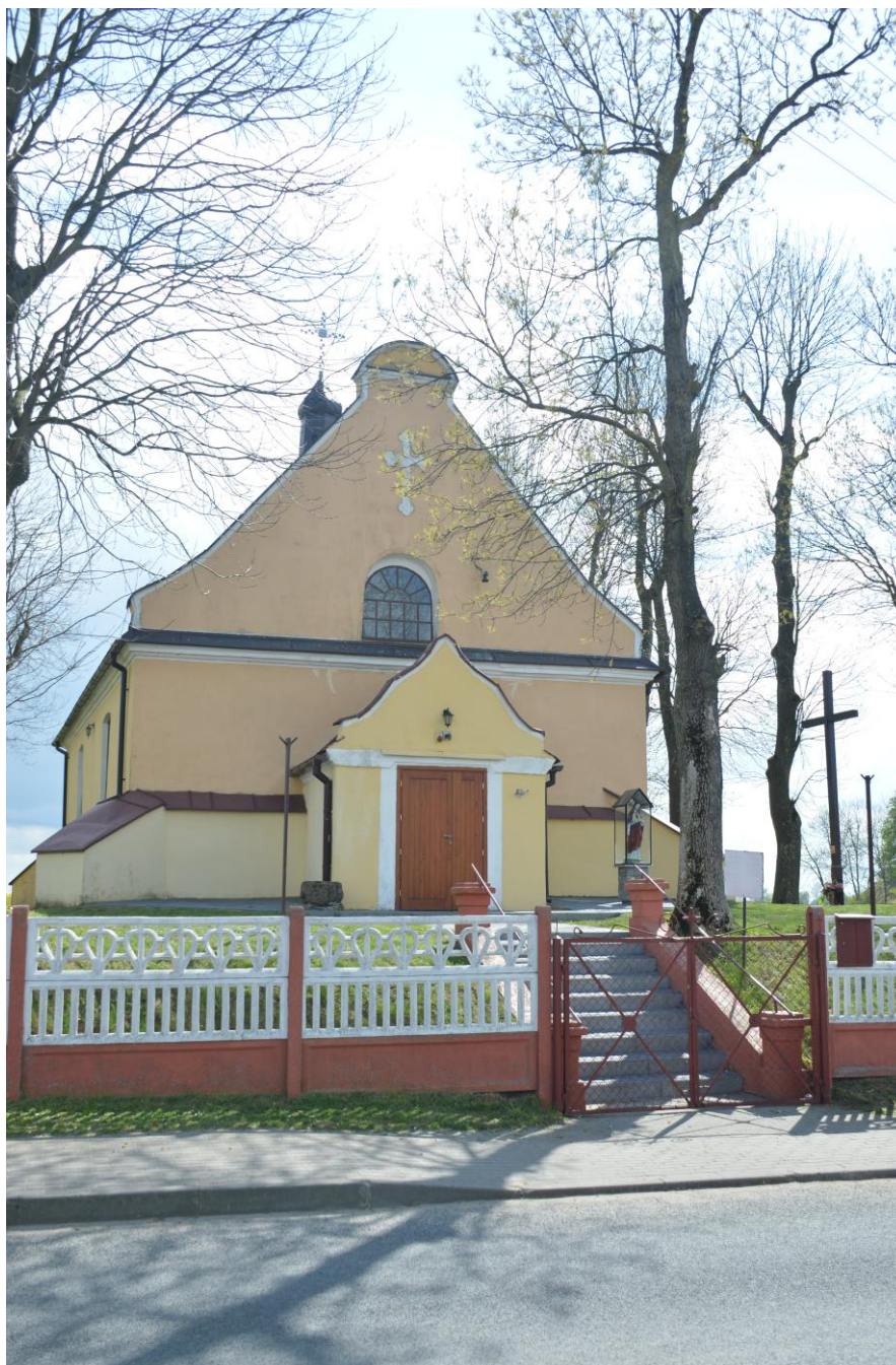
Kościół filialny rzymskokatolicki pw. Św. Piotra i Pawła w Grodzeniu - fot. Damian Siedlecki
